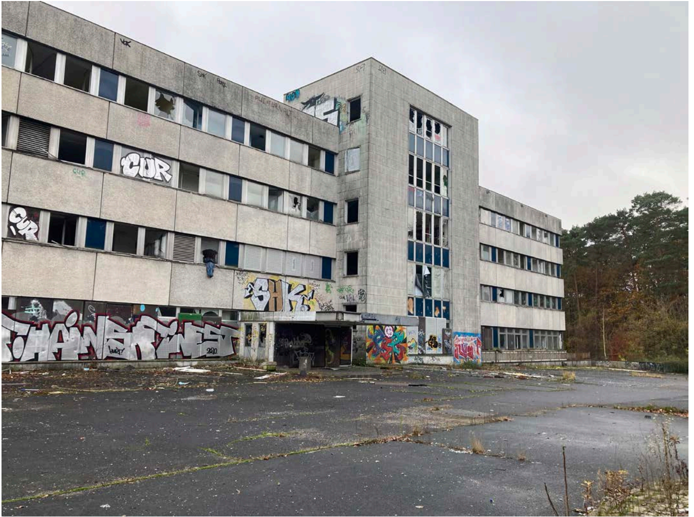
Abbildung 5: Blick auf das vordere Hauptgebäude, erkennbare Vandalismusschäden (eigene Aufnahme)
