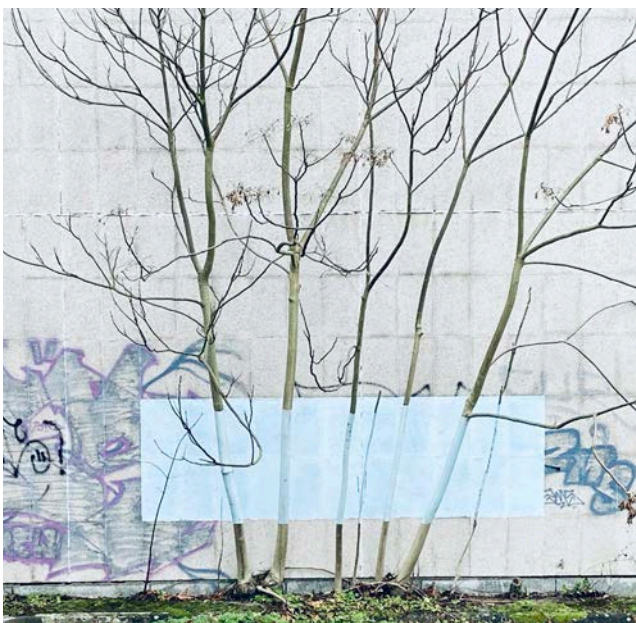
Abbildung 36: Eindrücke der Bestandssituation (eigene Aufnahme)
