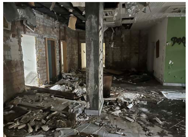
Abbildung 34: Zustand Erdgeschoss Haus 701
